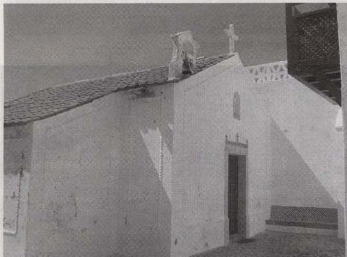
■ Exterior da capela, um anexo da residência do escritor
